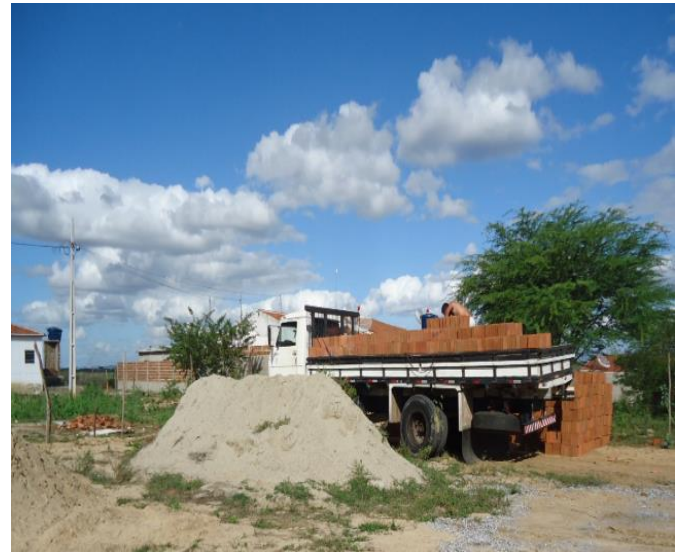
Figura 6- Início de obra
