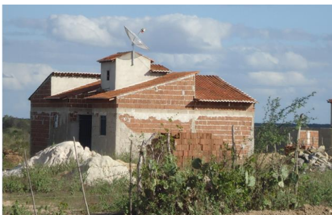
Figura 3 – Obra na cobertura
