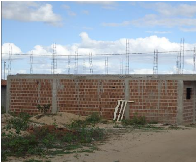
Figura 5 – Obra de 1º andar
