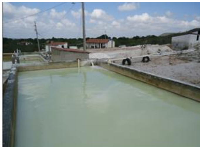
Figura 10 – Tanques decantação
