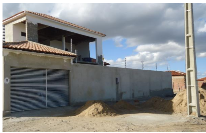
Figura 4- Obra em acabamento
