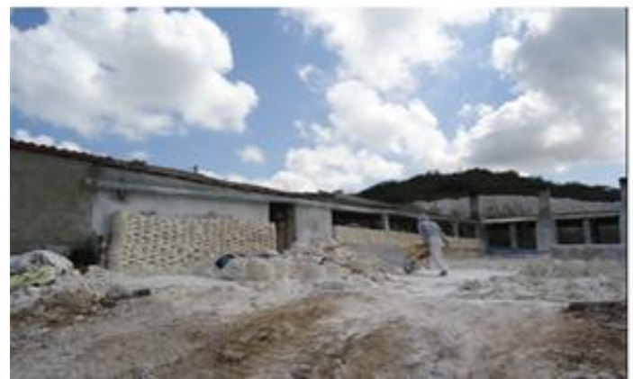
Figura 8 – Instalações industriais do caulim
