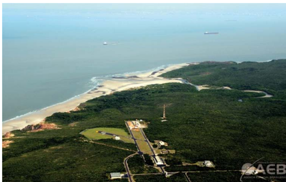
Figura 9 – Instalações do CLA próximas ao mar
