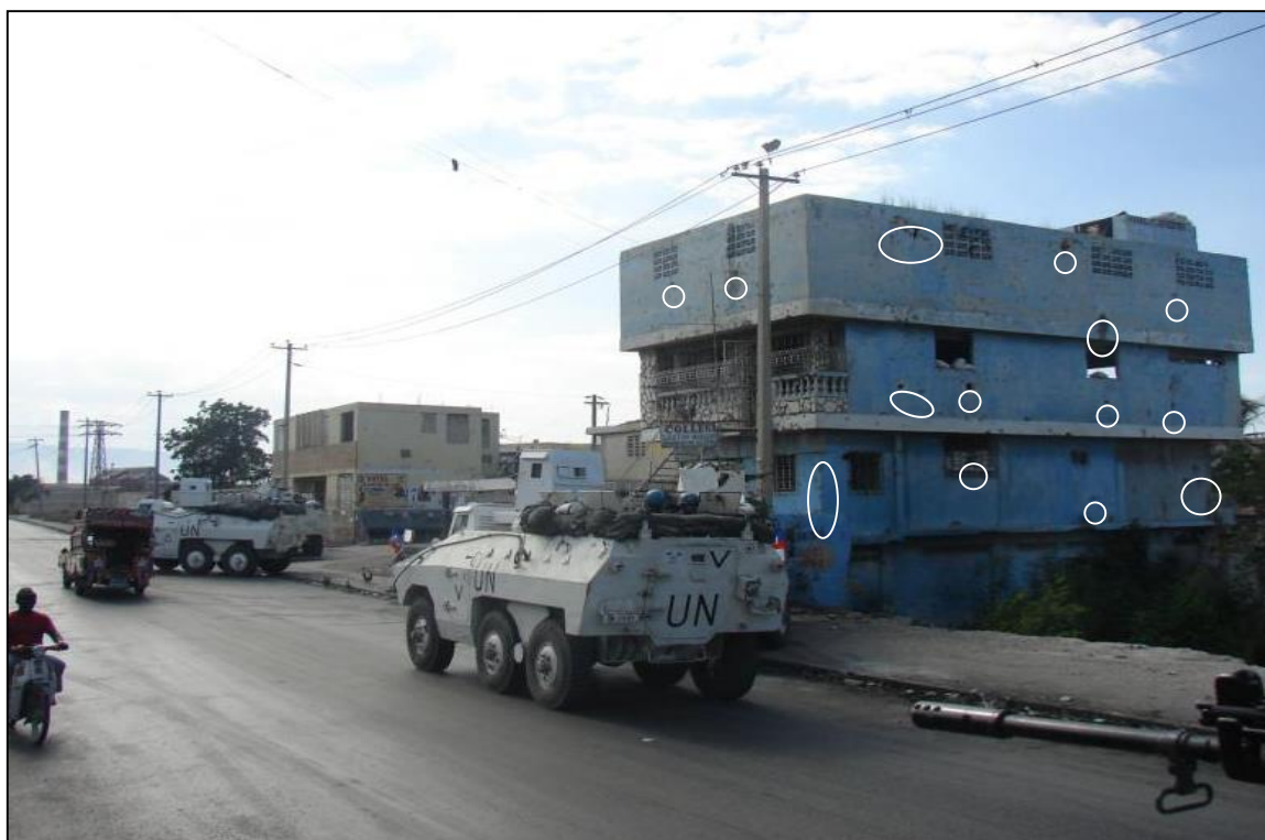
Imagem 8 – VISTA DO PONTO FORTE CASA AZUL
