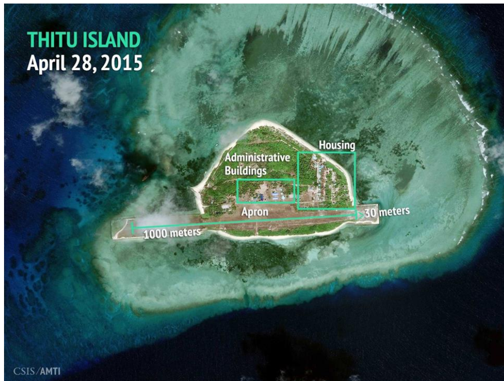
Figura 21: Melhorias feitas no Thitu Island pertencente às Filipinas
