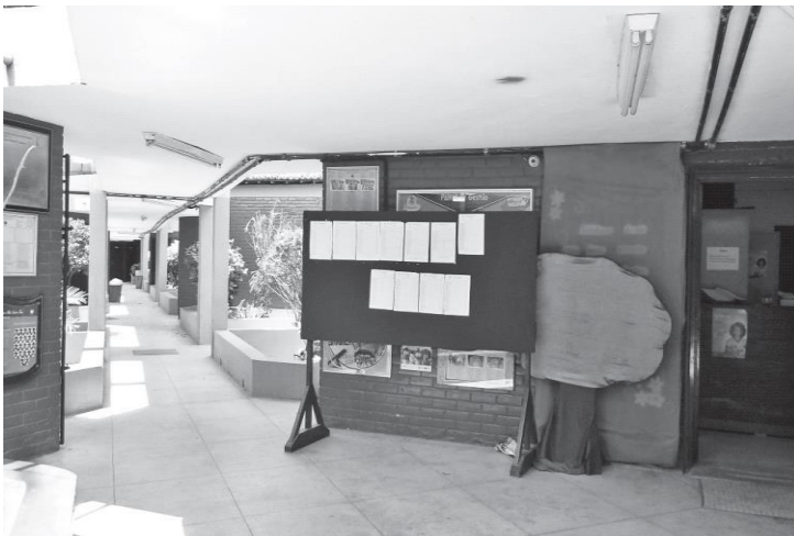
Figura 12 – Parte interna – entrada direita (Foto Lúcia Farias 2017)
