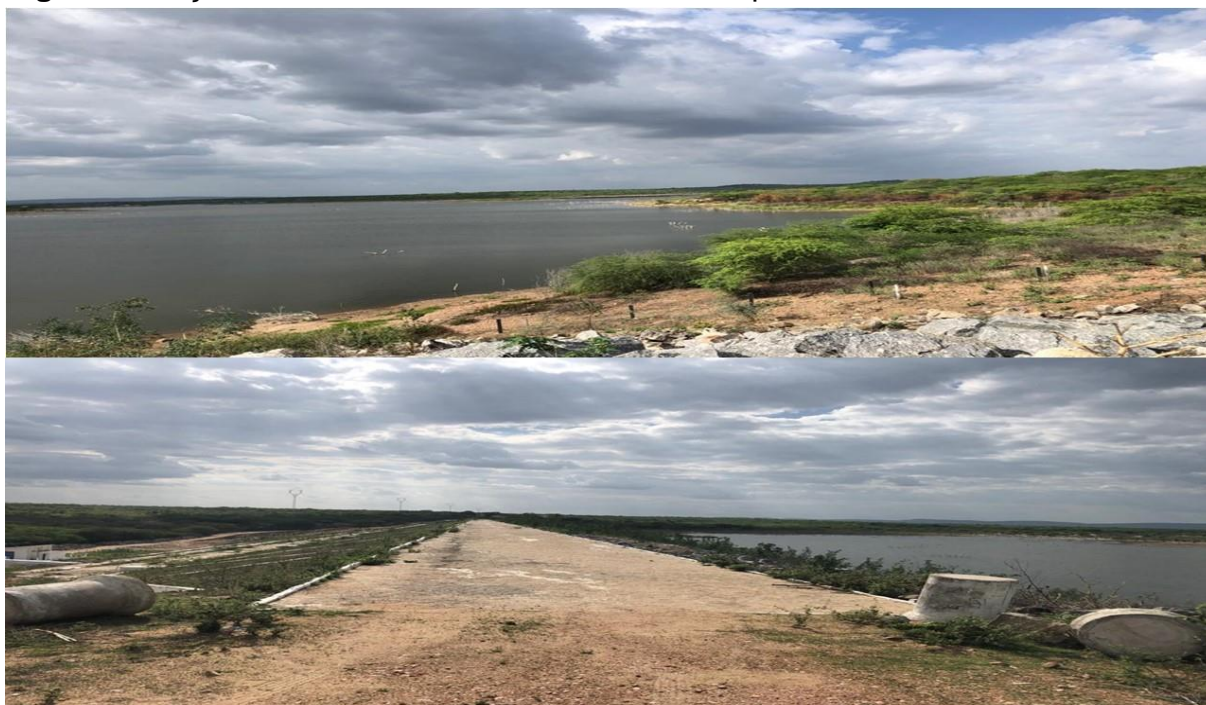
Figura 3 – Açude de Mucutu, visto de Juazeirinho, após reforma realizada
