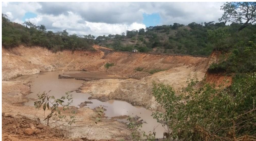
FIGURA 13: CONSTRUÇÃO DE BARRAGEM EM TERRENO DA HORTALIÇAS SEMPRE VERDE
