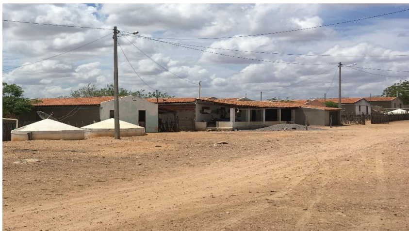
FIGURA 7 – CISTERNAS DE 16.000 LITROS NAS RESIDÊNCIAS EM FIRMEZA
