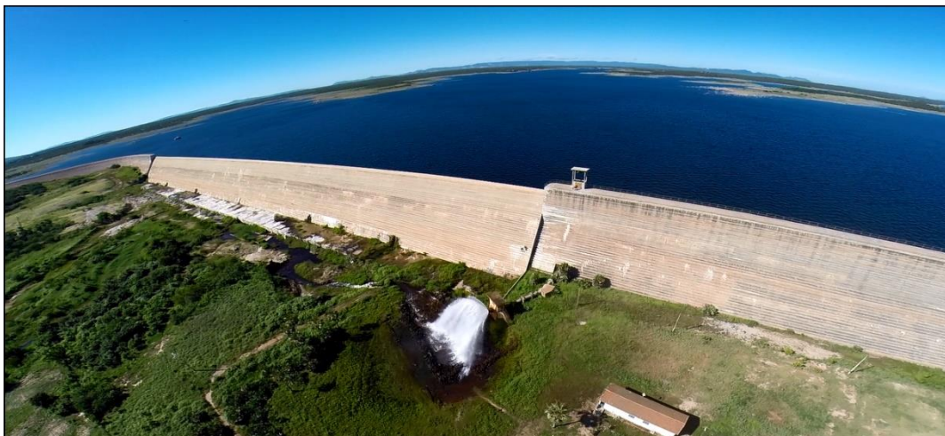
FIGURA 8 - BARRAGEM JESSÉ PINTO FREIRE
