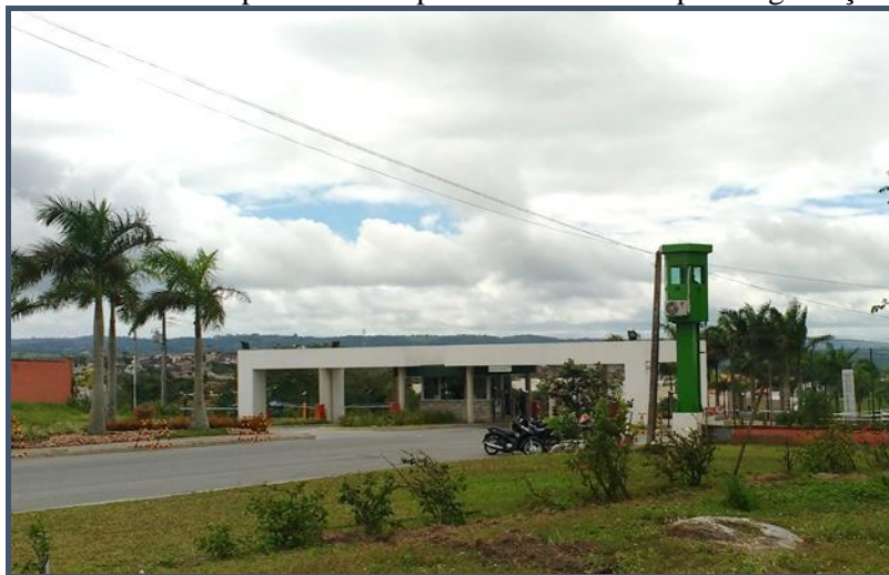
Figura 21 – Portaria Alphaville Campina Grande e torre para segurança armada
