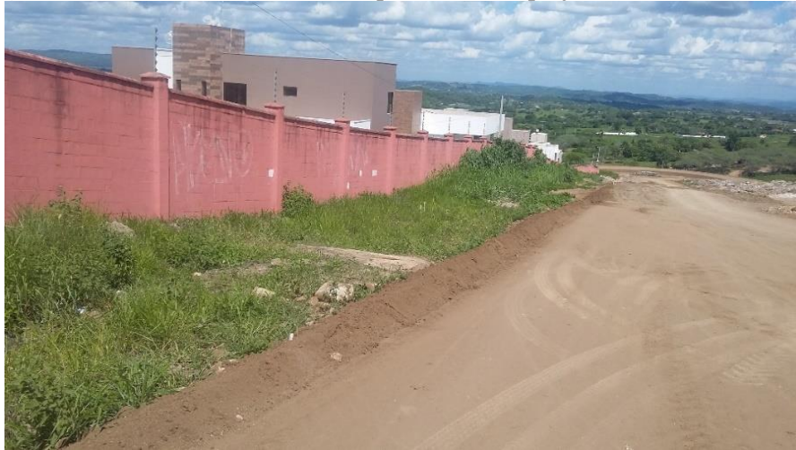
Figura 9 – Lateral do Loteamento Alphaville – rua projetada, sem asfaltamento
