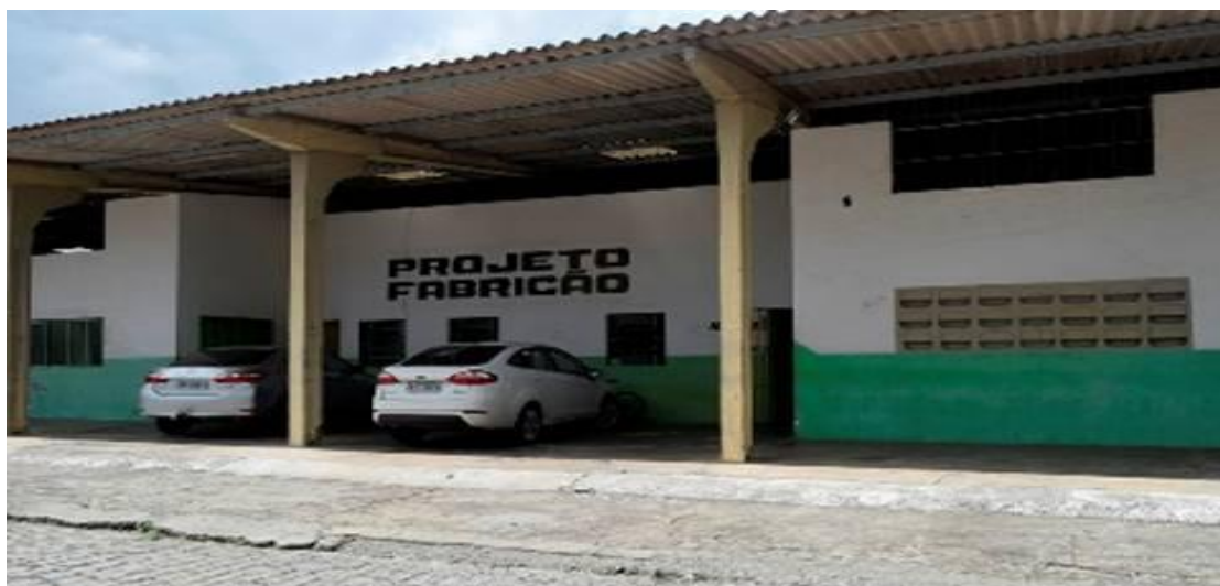
Figura 34. Vista da estrutura externa do Fabricão. Bairro Santo Antônio, Campina Grande/PB
