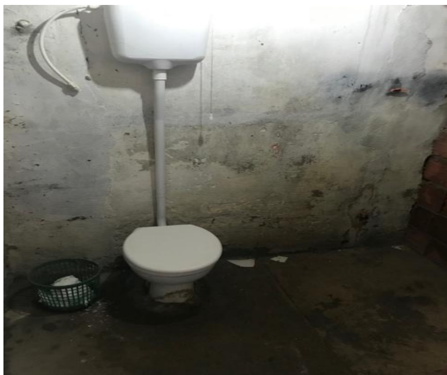
Figura 16 – Residência da Mãe “Coroa de Frade” – banheiro
