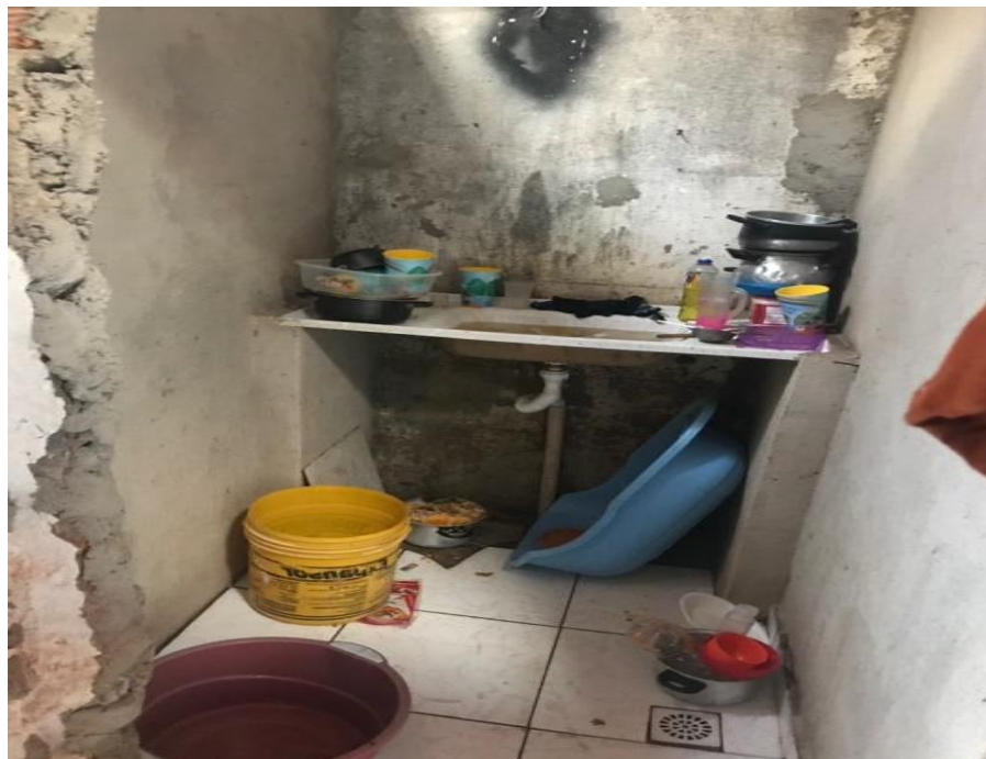
Figura 14 – Residência da Mãe “Coroa de Frade” – armazenamento de água
