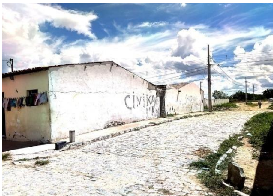
Figura 12 – Residência da Mãe “Coroa de Frade” – vista lateral externa
