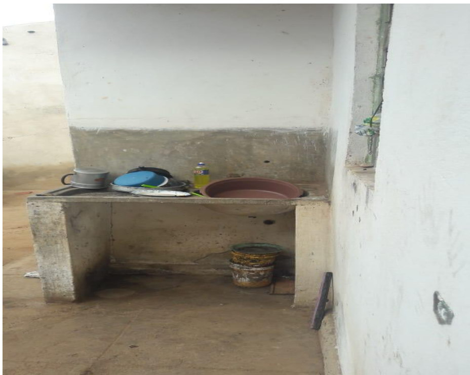
Figura 23 – Residência da mãe “Velame” – lavanderia
