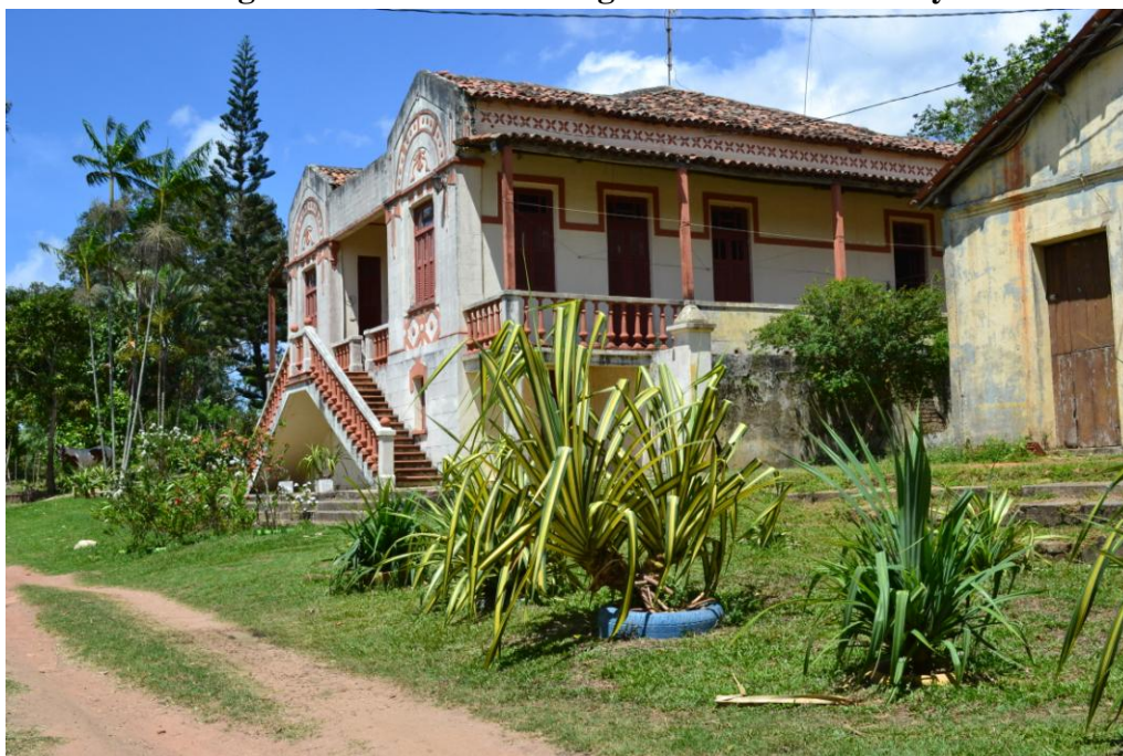
Figura 13 – Fachada – Engenho Várzea do Coaty
