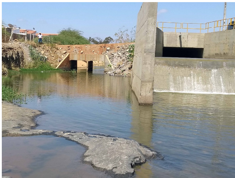
Figura 21 – Encontro da desembocadura do Eixo Leste (lado direito) com a desembocadura do canal de esgoto (lado esquerdo), na calha do rio Paraíba em Monteiro
