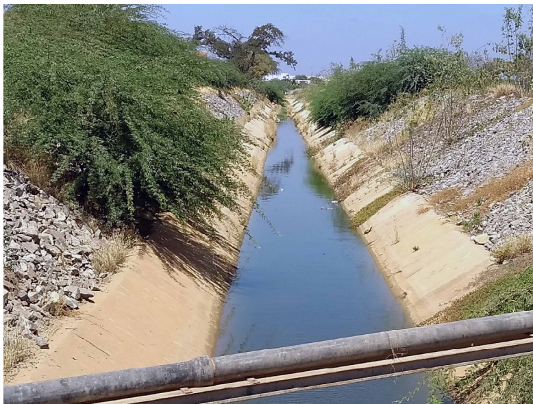
Figura 14 – Canal de esgoto localizado paralelamente ao canal submerso da transposição do São Francisco
