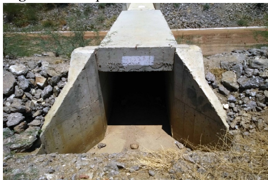
Figura 06 – Aqueduto sobre o canal do PISF
