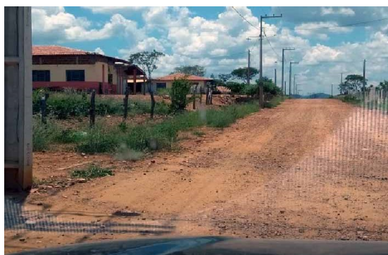
Figura 34 – Avenida no interior da Agrovila Lafayette
