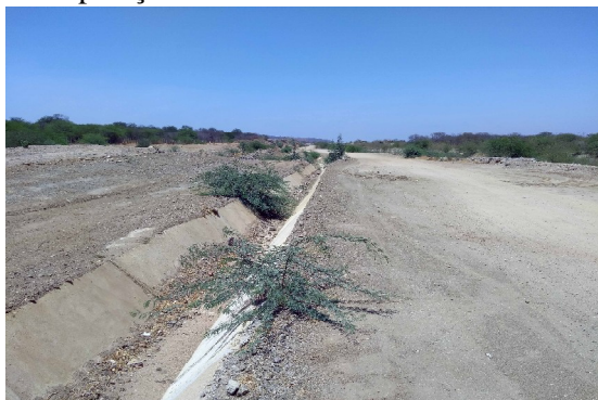
Figura 05 – Canal paralelo ao canal da transposição
