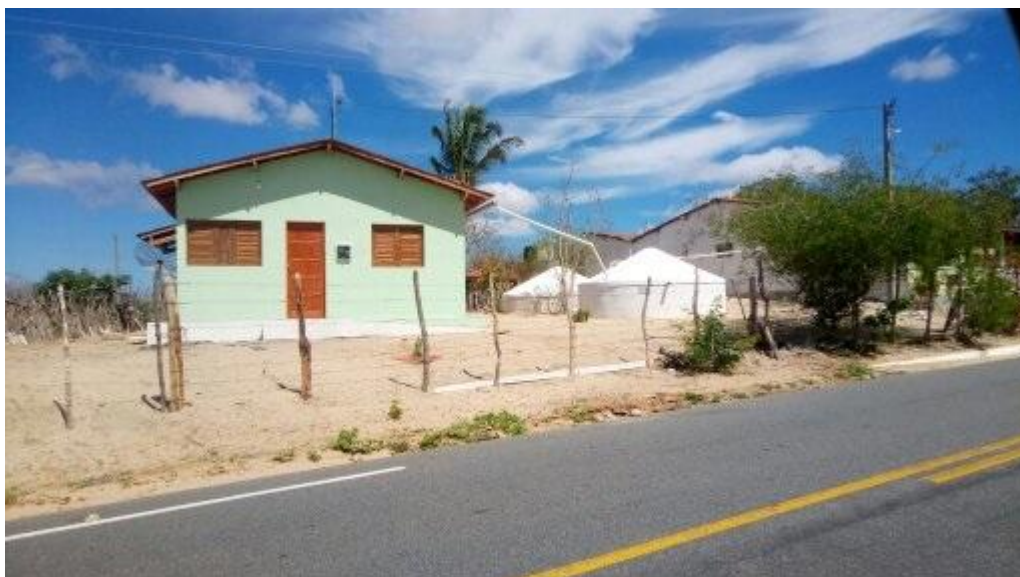
Figura 4 - Tipo de captação de água das chuvas - cisternas do sertão nordestino.
