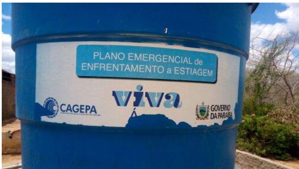
Figura 16 – Caixa d'água de armazenamento de águas subterrâneas
