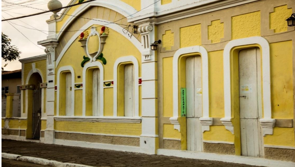
Figura 6. Vista da fachada de casarão construído no século XX na cidade de Ingá, PB.
