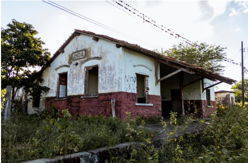
Figura 3. Vista da estação Ferroviária de Ingá, PB
