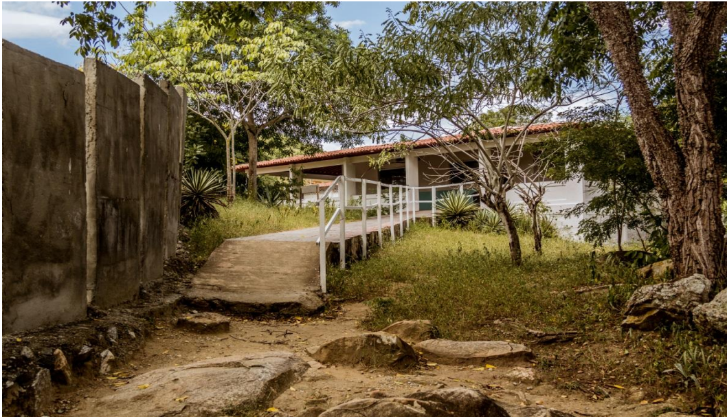
Figura 12. Vista da rampa de acesso ao sítio Itacoatiara, Ingá, PB.
