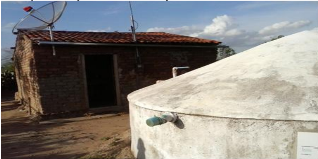
Figura 20. Exemplo de residência no município de Barra de Santana, PB, com 35 m 2 .
