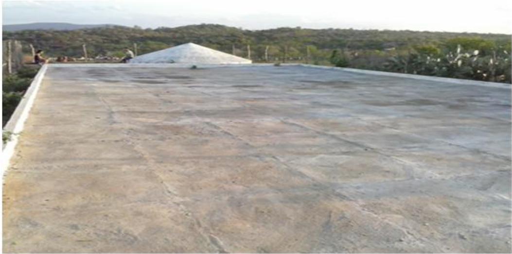
Figura 15. Primeiro calçadão de cimento para captar água da chuva em Barra de Santana, PB.
