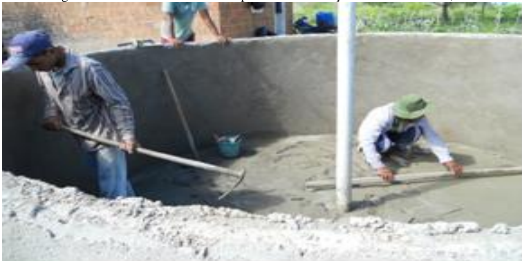
Figura 13. Vista de uma cisterna de placas em construção. Barra de Santana, PB.
