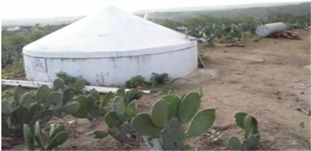
Figura 14. Vista de uma cisterna de placas construída. Barra de Santana, PB.
