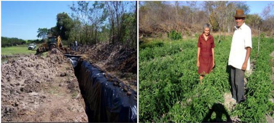
Figura 1. Vista da construção de uma barragem subterrânea (A) e com cultivos (B).
