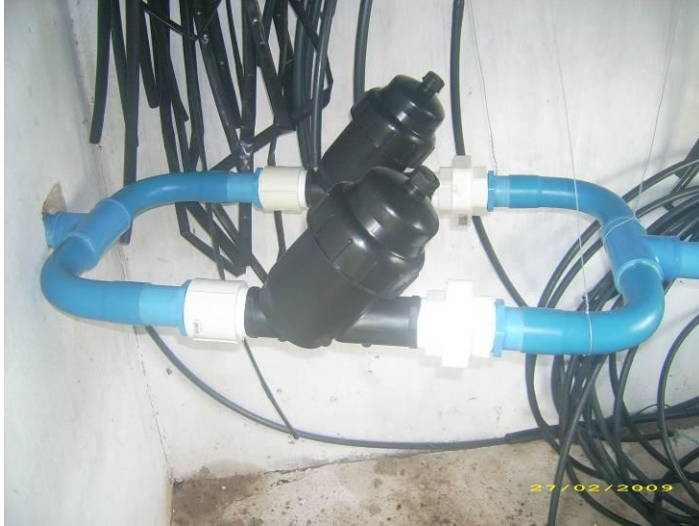
Sistema de filtragem da água de irrigação
